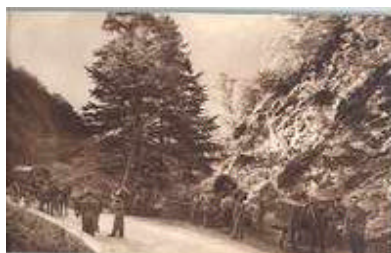
Groupement n°10, Saint-Laurent-du-Pont Le relai de ravitaillement au pont Saint-Bruno. Coll. MRDI
