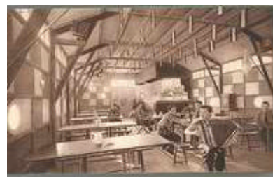
Groupement n°10, Saint-Laurent-du-Pont Groupe de Marfay, le foyer. Coll. MRDI
