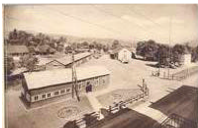
Groupement n°10, Saint-Laurent-du-Pont Vue d'ensemble du PC. Coll. MRDI
